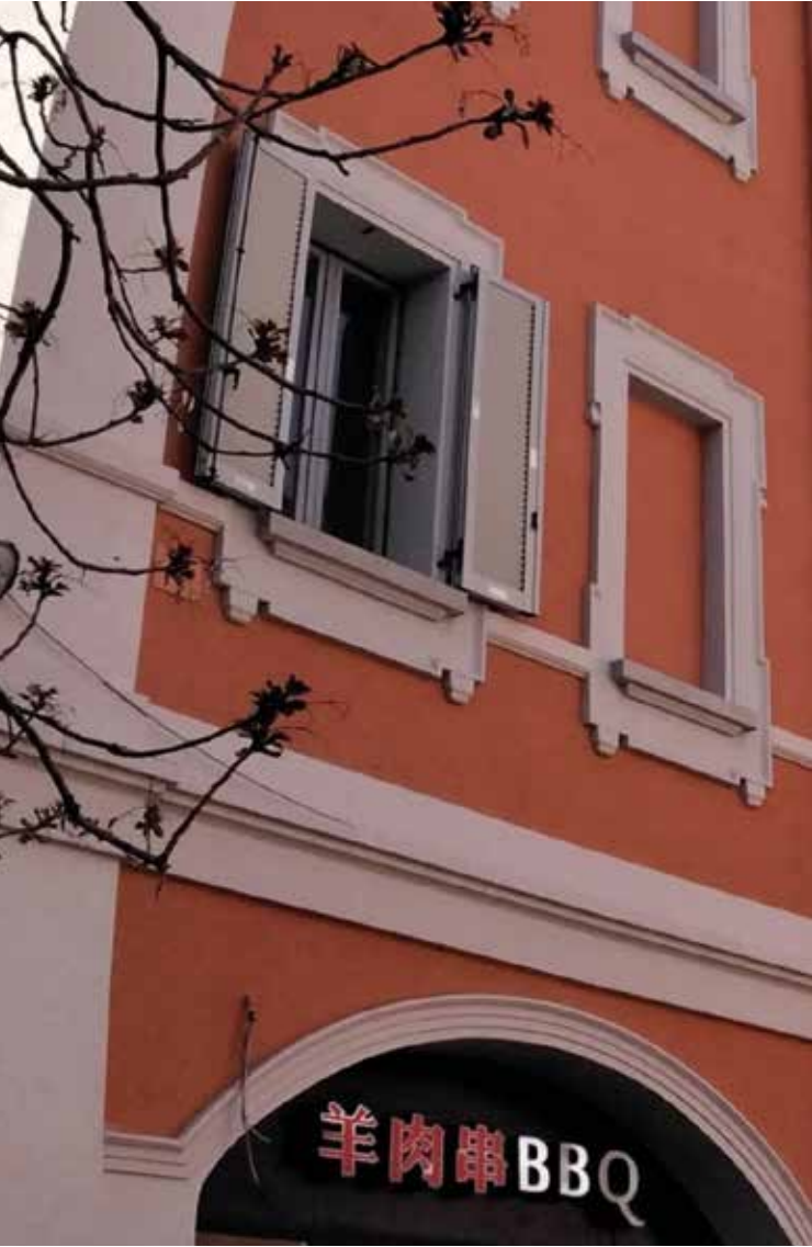
■ Milano. A seguito del risanamento delle facciate esterne dell’immobile, Eleni Decor ha prodotto fedelmente su disegni del committente tutti i particolari decorativi che prima dell’intervento erano in cemento.
