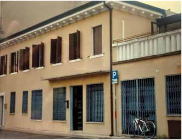
■ Prima e dopo: intervento di riqualificazione energetica e architettonica di un fabbricato in provincia di Padova.
