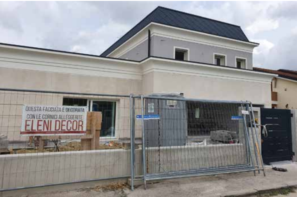
■ Milano. A seguito del risanamento delle facciate esterne dell’immobile, Eleni Decor ha prodotto fedelmente su disegni del committente tutti i particolari decorativi che prima dell’intervento erano in cemento.
